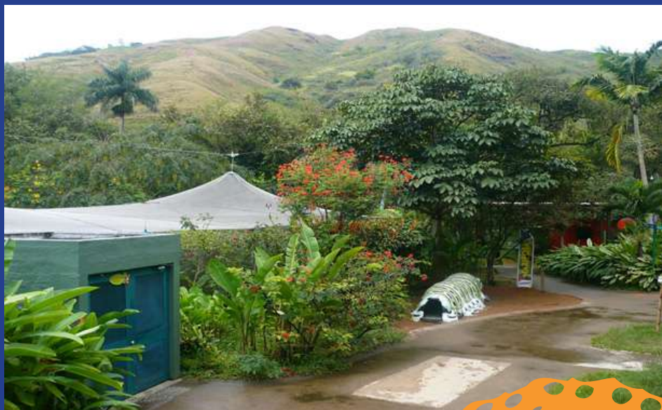
Figura 14. Vista exterior del mariposario del Zoológico de Cali detállese el diseño, la estructura y materiales de construcción.
